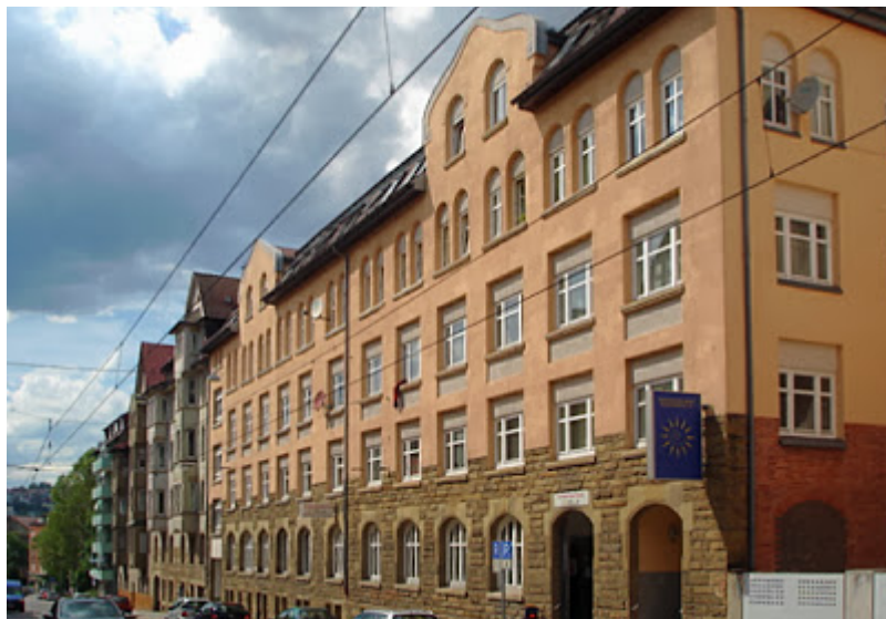
La sede de la antigua fábrica de cigarrillos Waldorf-Astoria. (Foto CC de Stephan Klage, edición de Parzi, via Wikimedia Commons)
